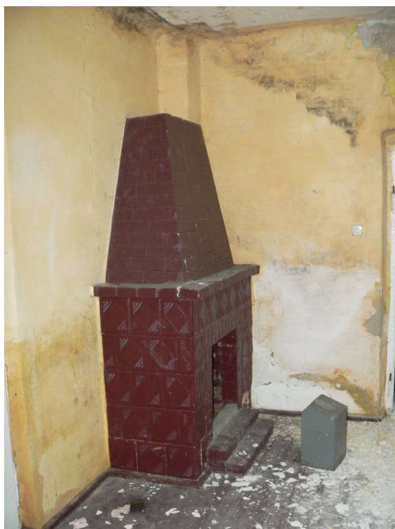
Wnętrze budynku, widoczne zawilgocenie ścian, odpowiednio wewnętrzna z lewej, zewnętrzna po zdjęcie po prawej.
